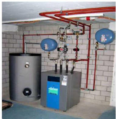
Wärmepumpe mit Wärmeverteilung
